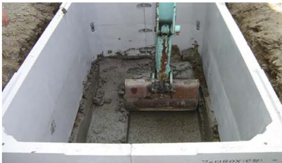
(3) バックホーでボックスの中を掘削する。
