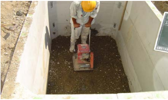
(9) 再生クラッシャーランを投入し転圧
