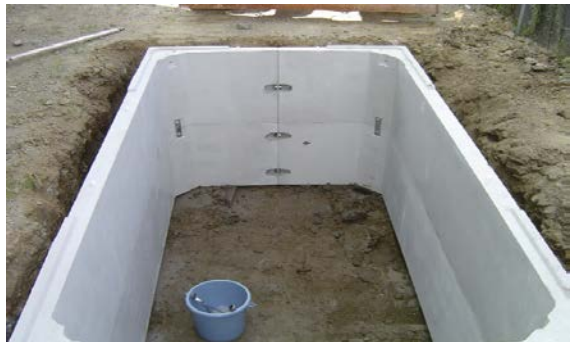
(2) 2段目（中段）を組み連結する
