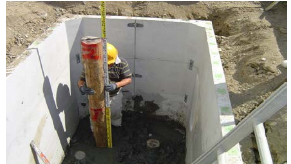
(3) バックホーでボックスの中を掘削する。
