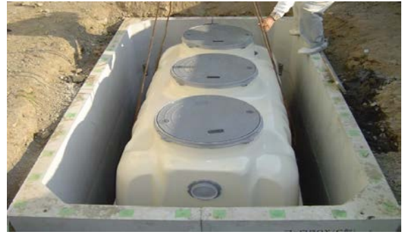
(12) 浄化槽の設置完了
