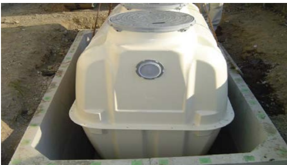
(11) 浄化槽を設置する
