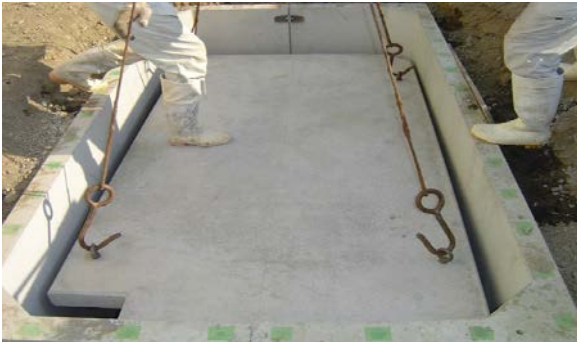
(10) ベースコンクリートを設置する
