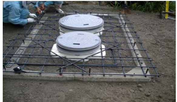
(13) 埋戻しを行い上部スラブの鉄筋を組む
