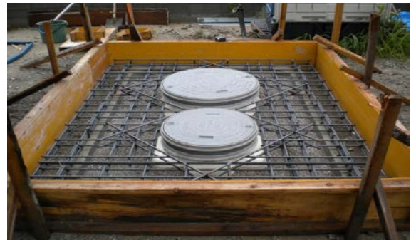
(14) 上部スラブの型枠を組む
