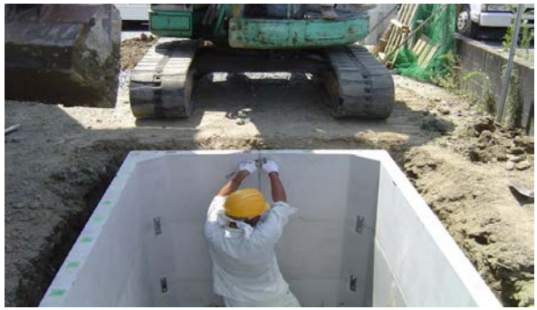
(5) 3段目（上段）を組み連結する
