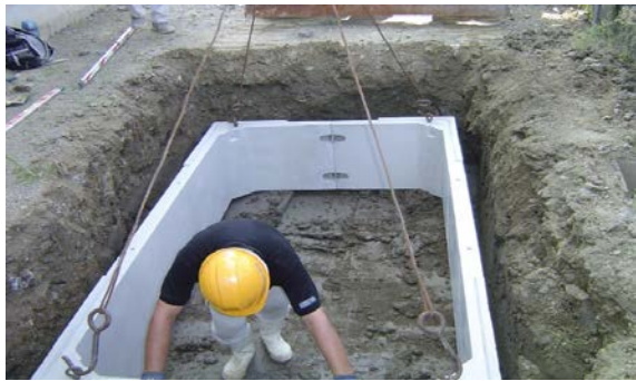
(1) 下段のBOX組んでを設置する
