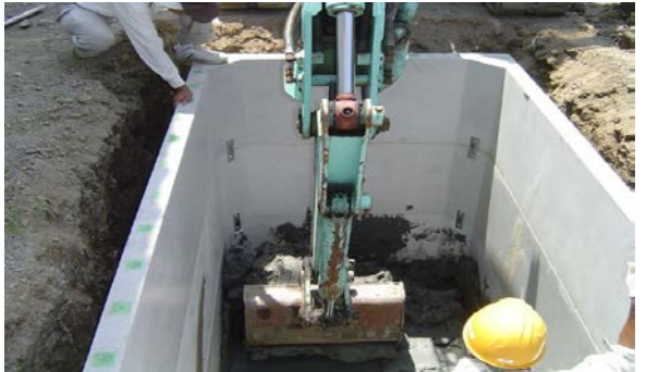
(6) 再度掘削をし所定の高さに仕上げる
